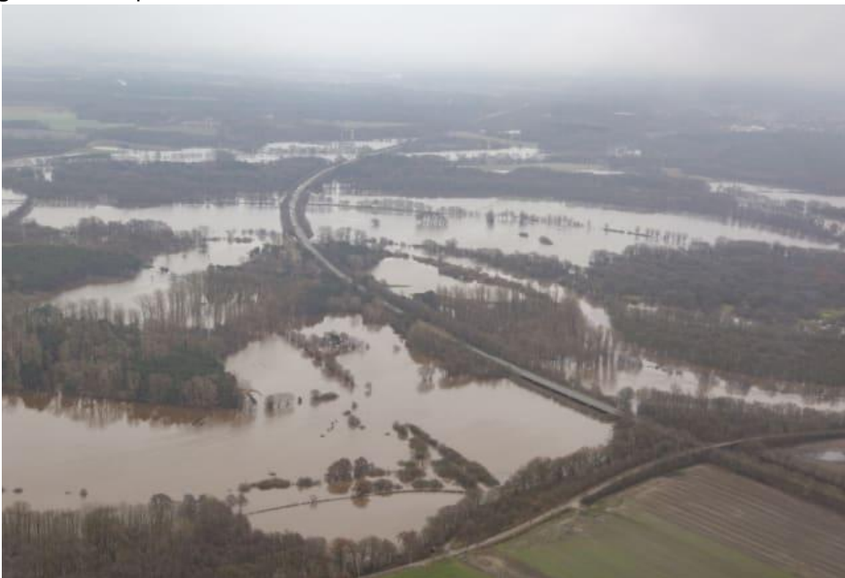
Figura 10: Después de las inundaciones en el Norte de Alemania
