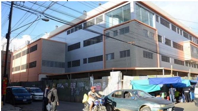
Imagen 1. Vista lateral del „Hospital Cochabamba“
